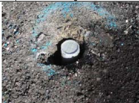
Tête du piézair avant la pose du regard
